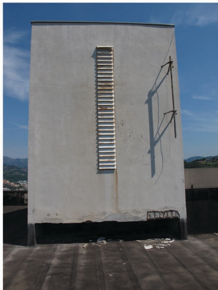
Dettaglio_Elementi metallici ossidati
