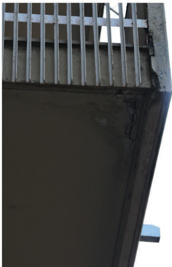
Balcone con infiltrazioni e mancanza Dettaglio_Prospetto Nord
