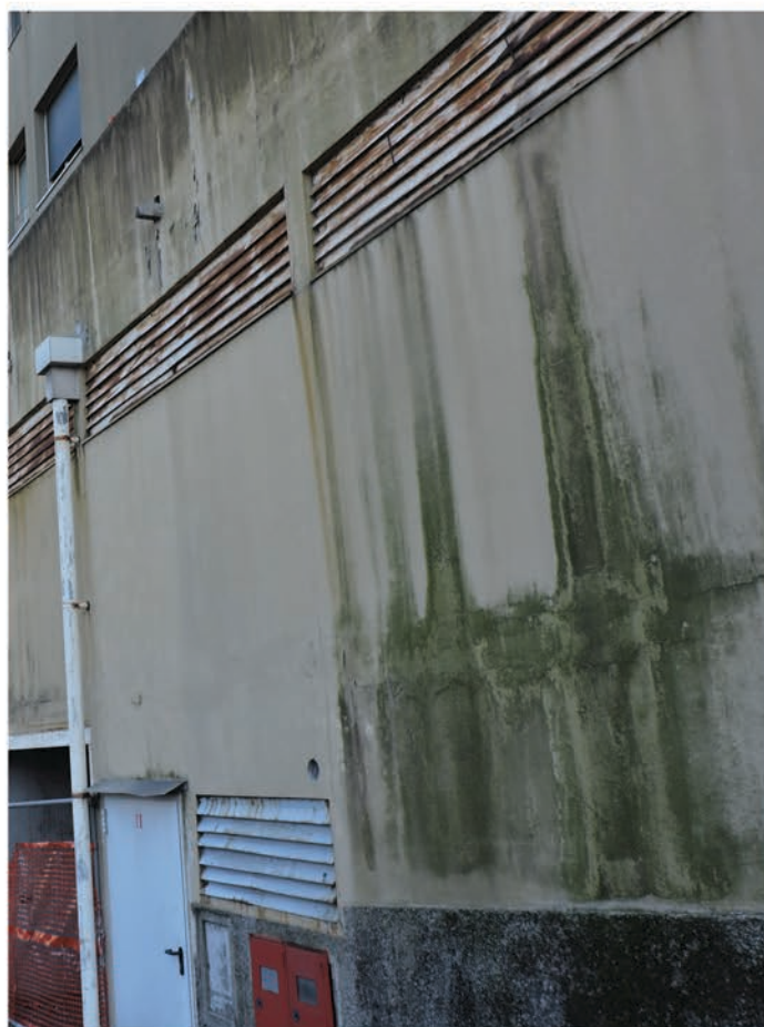
Scrostamento degli strati superficiali Dettaglio_Prospetto Nord
