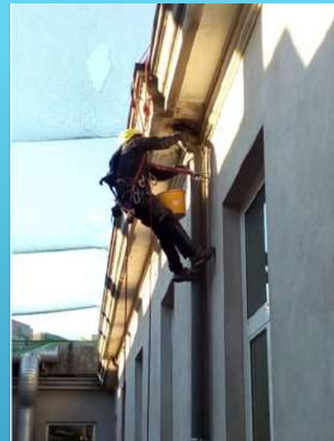
SCUOLA MEDIA PARINI MERELLO CSO GALILEO GALILEI 7: RIFACIMENTO PLUVIALI E REVISIONE TRAMOGGE
