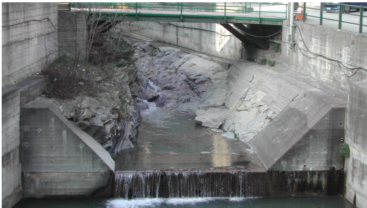
Figura 32 – Soglia a monte della briglia di intercettazione dei flottanti
