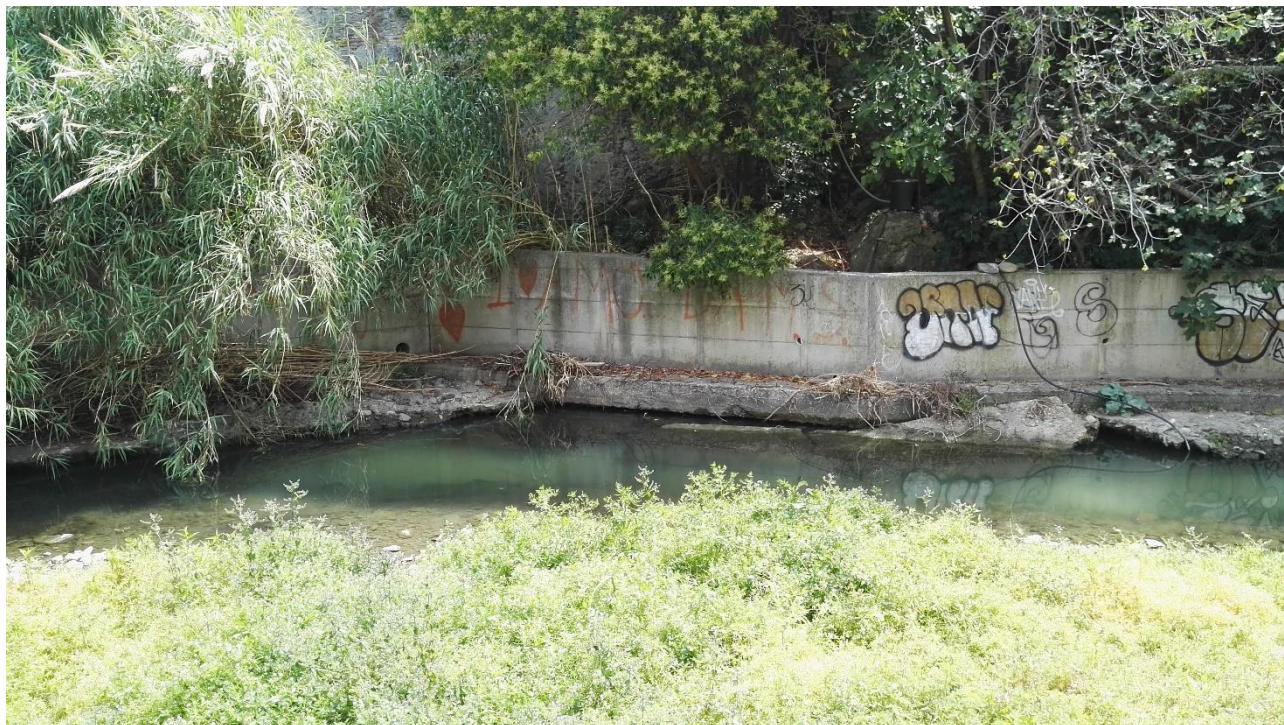
Figura 20 – (15) – Erosione localizzata della fondazione dell'argine in sponda sinistra.
