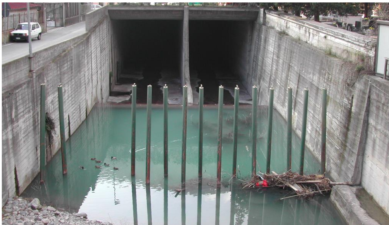
Figura 33 – Particolare del pettine di intercettazione dei flottanti
