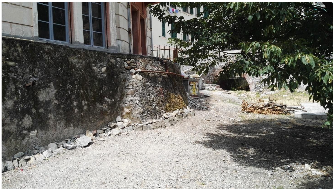
Figura 14 – (10) – Particolare delle abitazioni in sponda destra. La parete esterna delle case riveste il ruolo di argine
