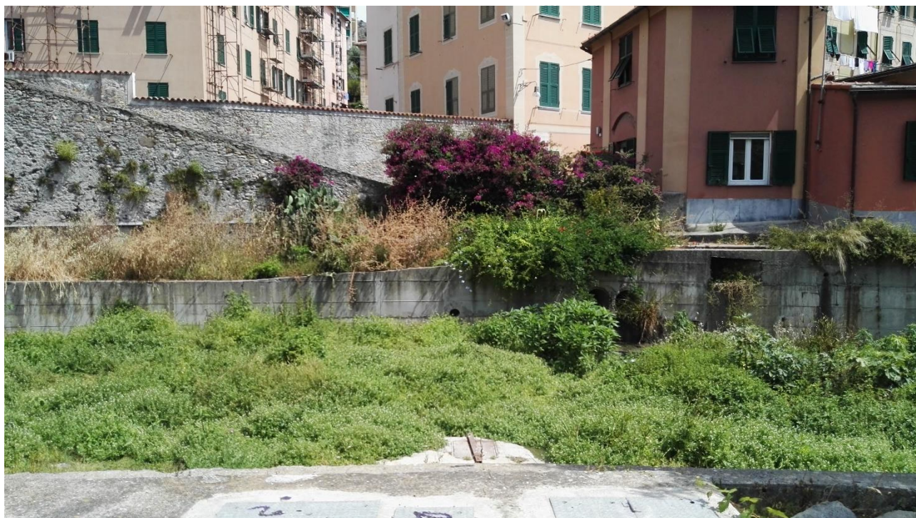
Figura 15 – (11) – Argine in sponda sinistra. Accesso in pietra al ponte romano e argine inferiore in cemento armato
