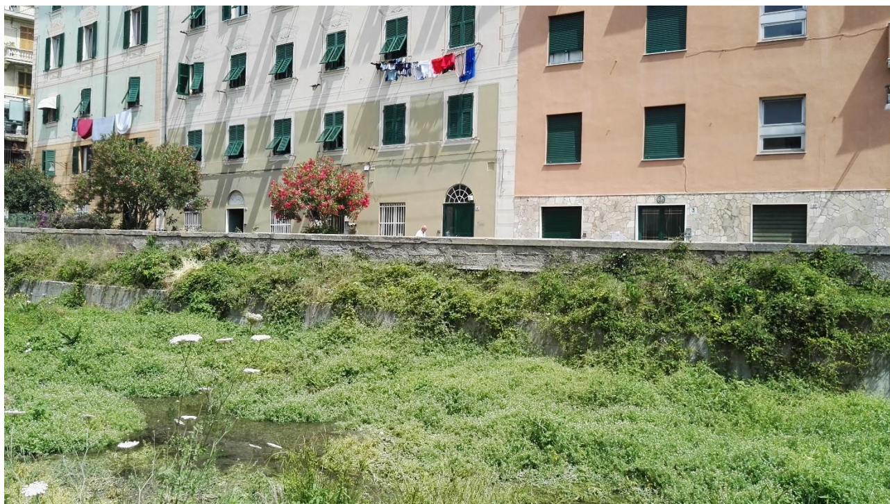
Figura 8 – (5) – Argini in sponda sinistra. Paramento in calcestruzzo a ridosso dell'alveo e muro in pietra a contenimento della strada
