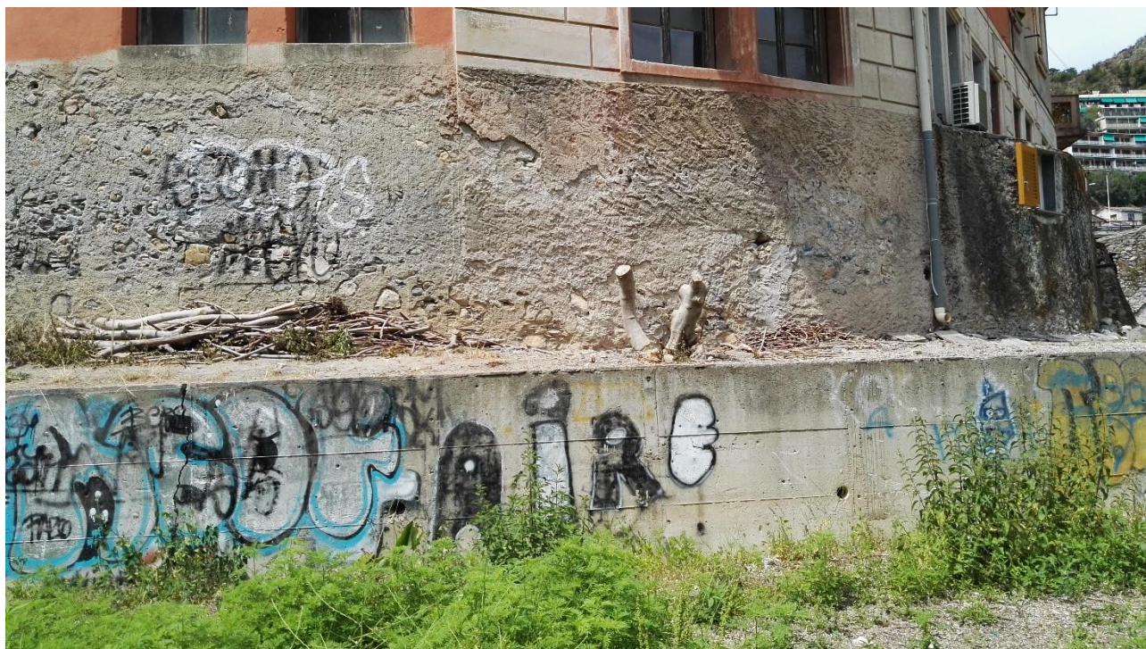
Figura 19 – (14) – Raccordo tra le case prospicienti l'alveo e l'argine inferiore in cemento armato in sponda destra
