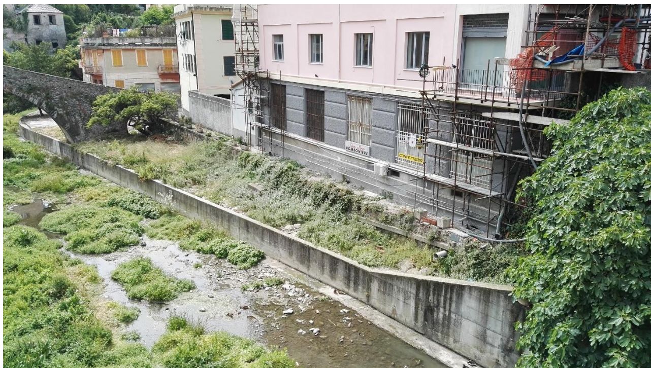
Figura 6 – (3) – Argini in sponda destra. Paramento in calcestruzzo a ridosso dell'alveo e muro in pietra a ridosso delle case
