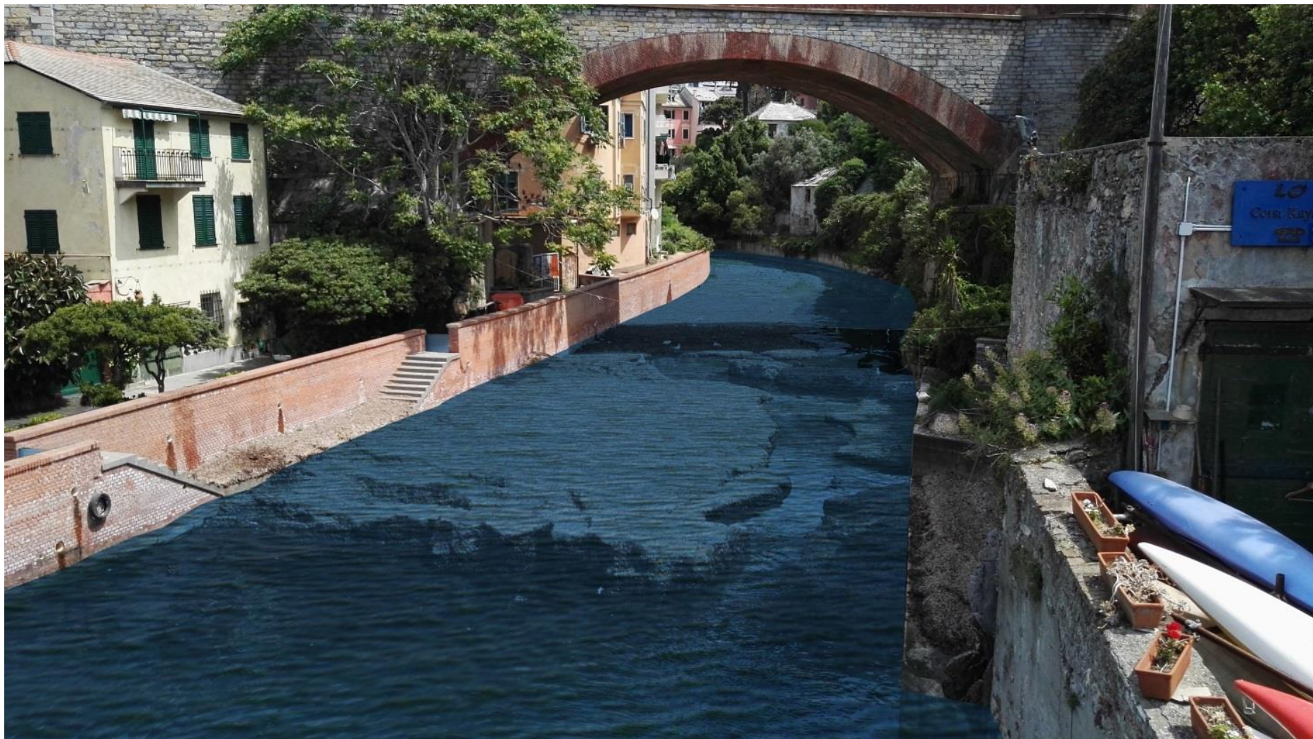
Figura 15 – Nuove arginature in mattoni – Tratto focivo - Argine destro
