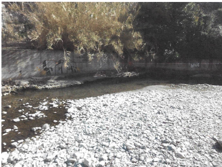
Vista della erosione con scalzamento delle fondazioni in sinistra idrografica
