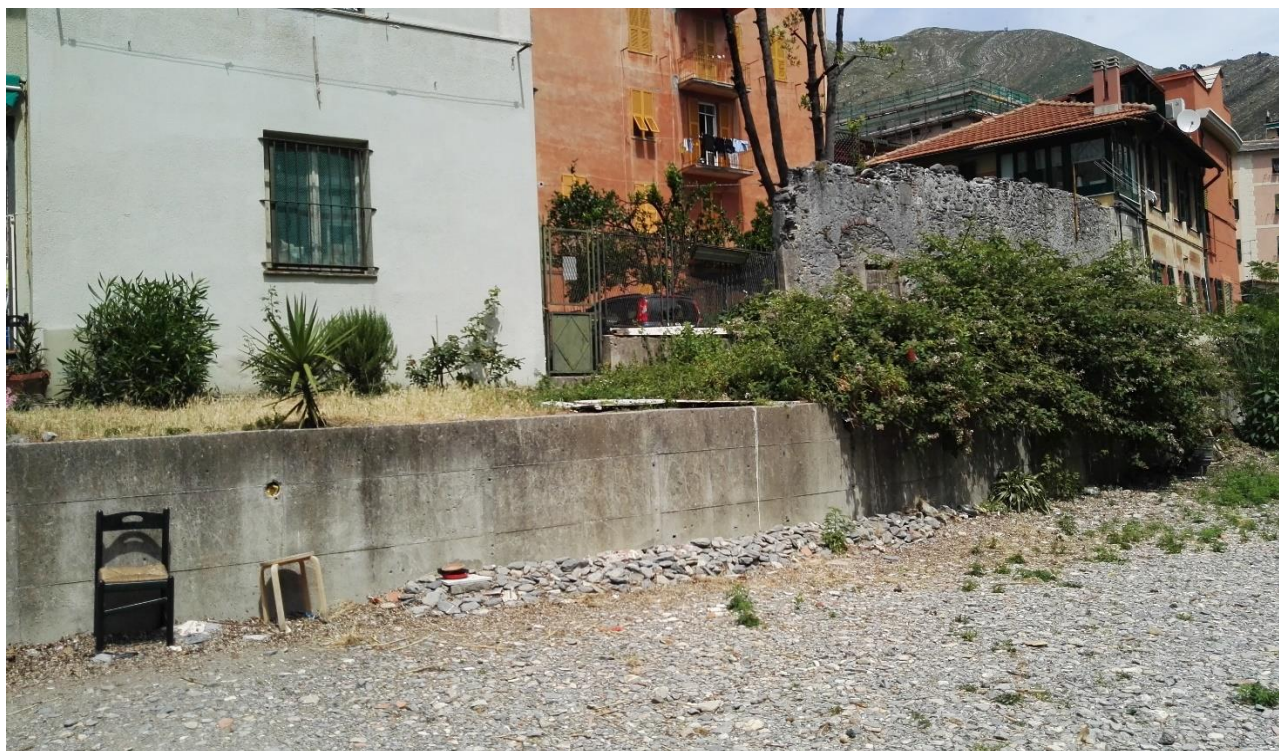
Figura 10 – Sponda destra a valle della curva – Edifici aggettanti in alveo
