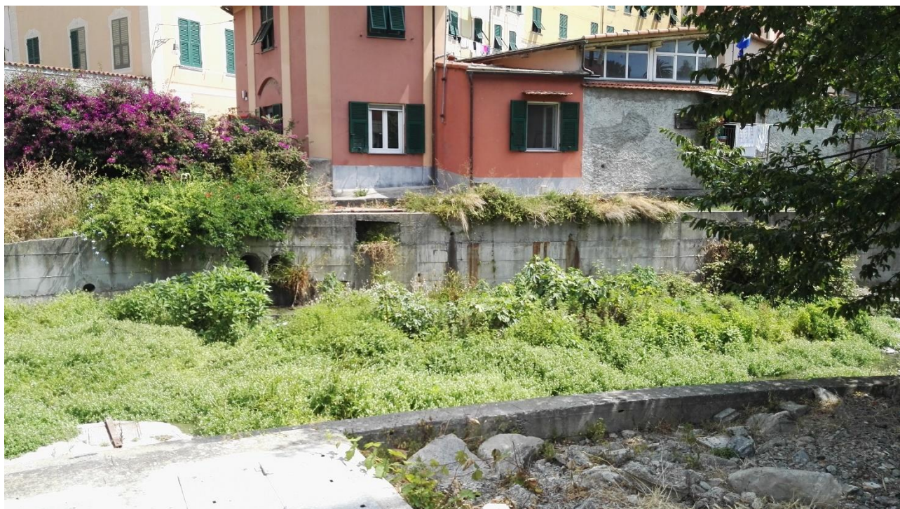
Figura 5 – Sponda sinistra a valle del ponte romano – Edificio aggettante in alveo
