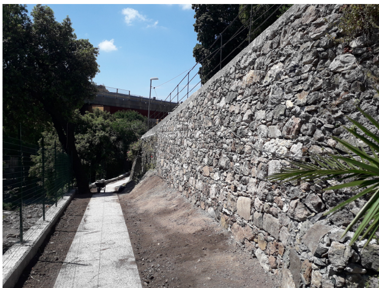
Figure 1: Esempio muro in pietra realizzato con precedente AQ
