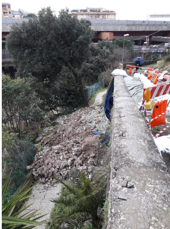
Figure 5: Crollo di un muro in pietra
