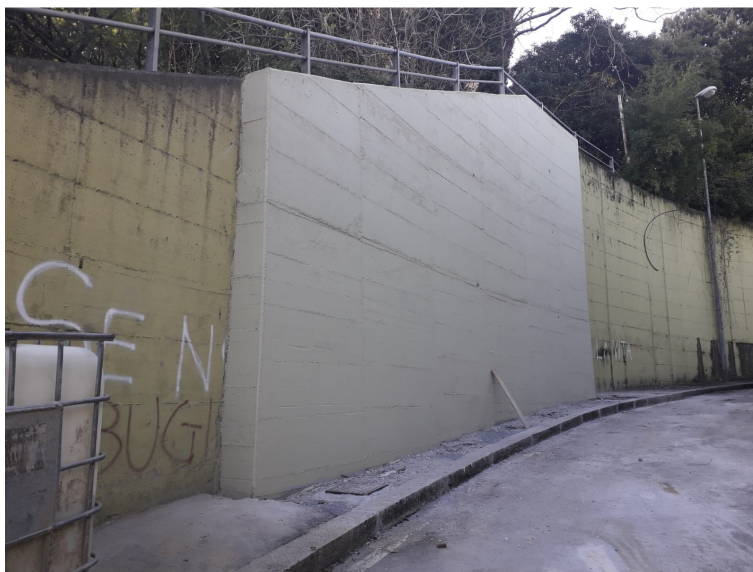
Figure 2: Esempio controparete in C.A. realizzato con precedente AQ
