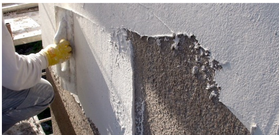
Figura 2 - Fasi di intonacatura e finitura
