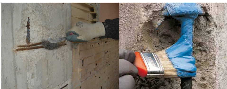
Figura 3 - Fasi di consolidamento opere in c.a.
