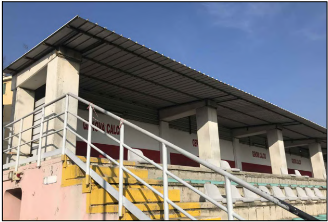
Vista 2 - Gradinate con copertura in lamiera grecata
