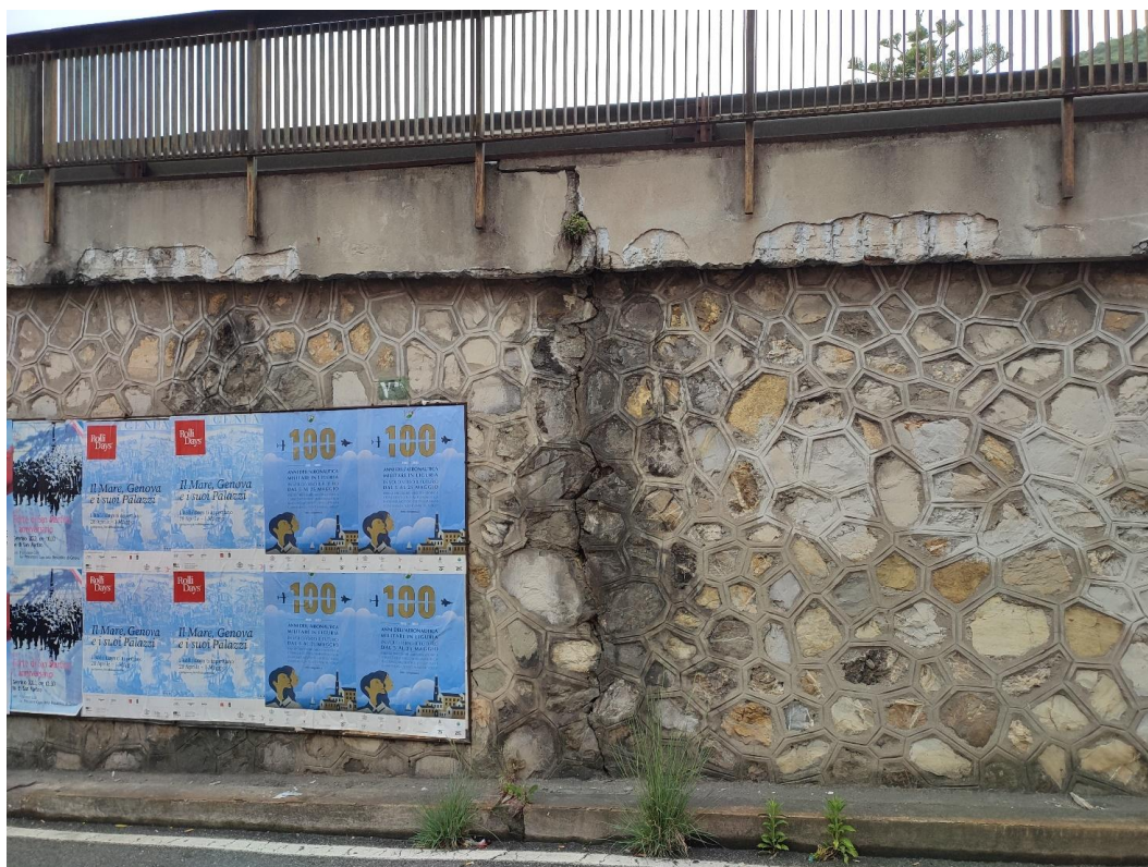
Figura 3 – Fessura verticale in corrispondenza del muro frontale del muro andatore a sostegno del rilevato
