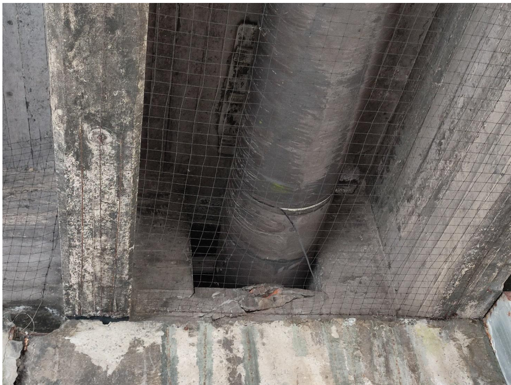
Figura 2 – Meccanismo fessurativo del traverso per effetto della rototraslazione del blocco muro frontale e muro andatore della spalla est
