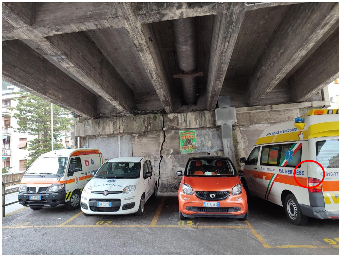
Figura 1 – Vista frontale lesione spalla EST
