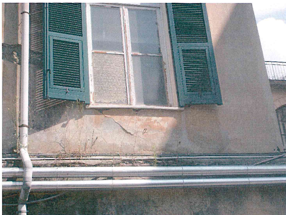
Img.3- 4 – dettagli parte terminale ala est del prospetto principale orientato a sud. Si osserva l'estesa presenza di patina biologica e di vegetazione infestante nel cornicione, erosione efflorescenza salina e macchia da colatura. Lacune di intonaco dietro il pluviale.
