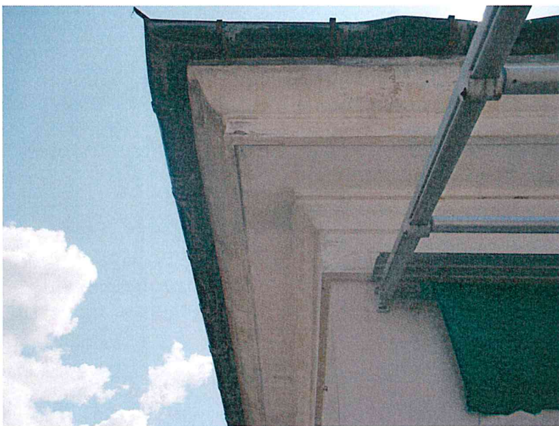
Img. 20-21 –pellicolazione ed esfoliazione coloritura basamento ala laterale sud. Cornicione sottotetto angolo sud-ovest, fessurazioni erosione
