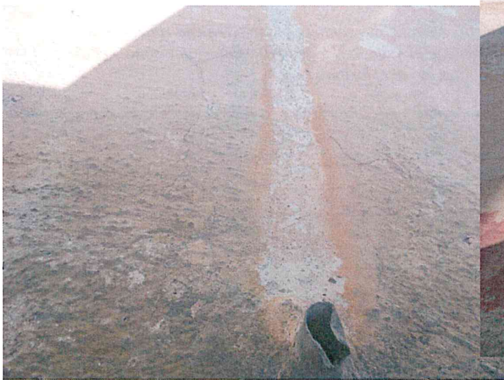
Img. 15-16 dettaglio dell'intonaco sotto una finestra del copro centrale al secondo piano, colature, macchie, erosione della pitturazione
