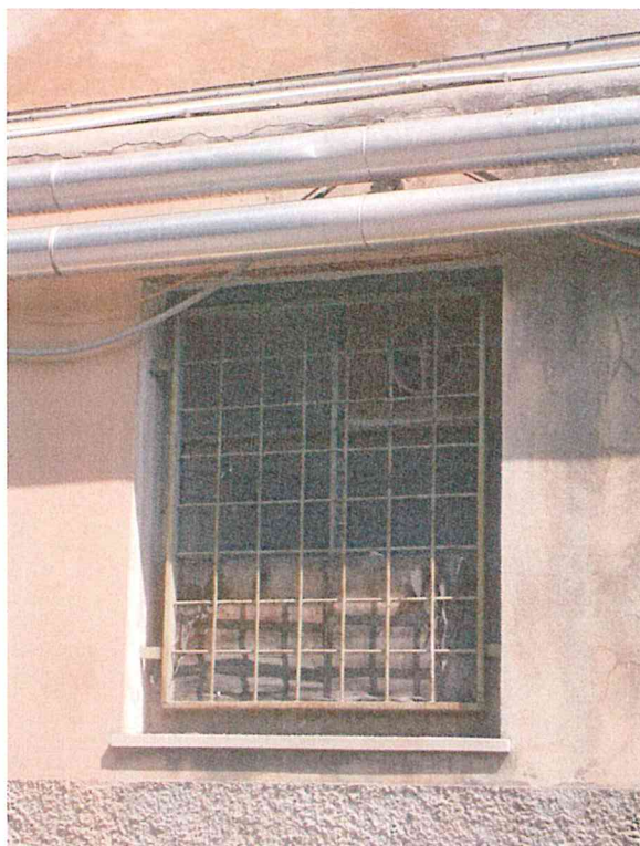
Img. 10 -11-12 – dettagli facciata principale, con depositi superficiali, lacune, distacchi di intonaco, fessurazione della sagoma decorativa del basamento tra piano terra e piano primo, in parte nascosto dalle tubazioni dell'impianto di riscaldamento, decoesione e rigonfiamenti della fascia a stollato
