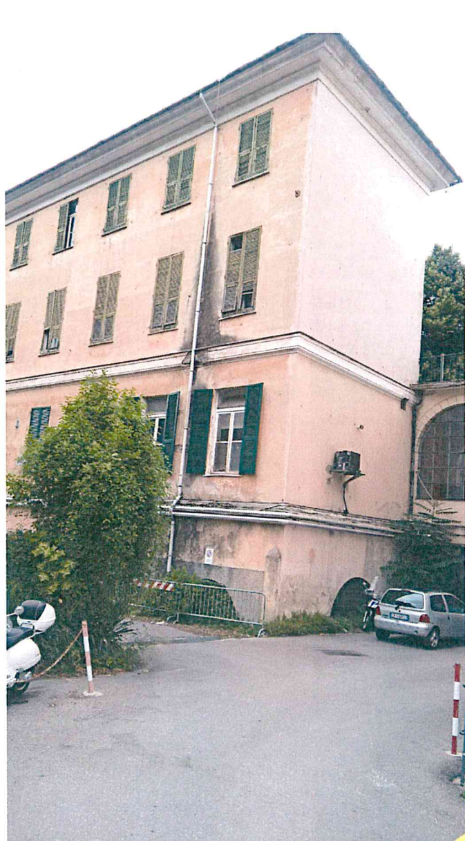
Img. 1-2- angolo tra ala est e prospetto laterale verso Asl: presenza di macchie, rottura dei pluviali, presenza di vegetazione infestante negli attacchi a terra e di patina biologica lungo le vie di percolazione dell'acqua. Sono inoltre visibili erosione, distacco e lacuna delle malte di rivestimento
