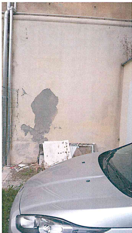
Img. 20-21 –pellicolazione ed esfoliazione coloritura basamento ala laterale sud. Cornicione sottotetto angolo sud-ovest, fessurazioni erosione
