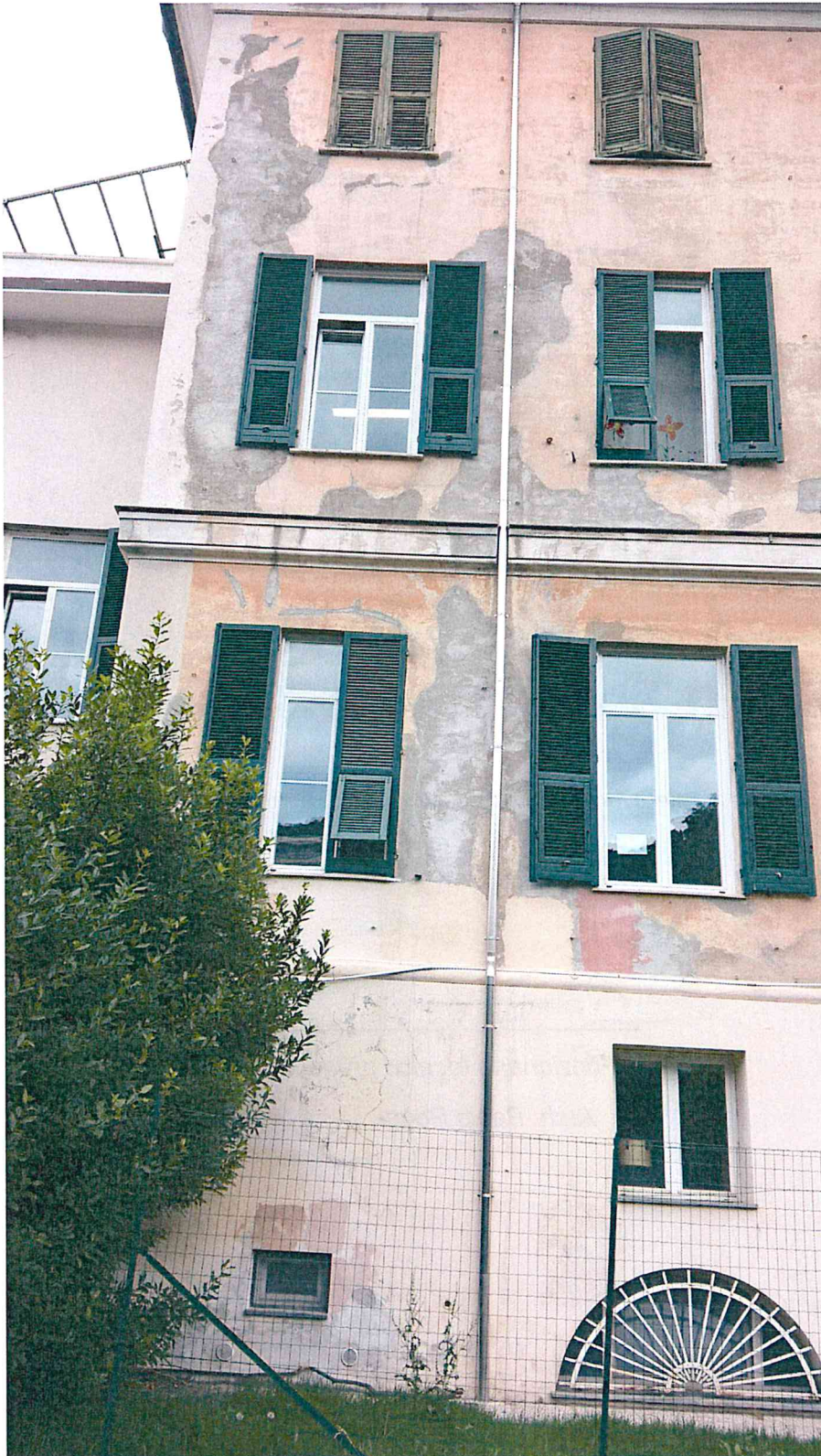
Img. 19 – Ala laterale sud verso angolo ed ingresso scuola; rappezzi di intonaco a calce su presedenti distacchi. Nell'ala sud i pluviali e la gronda sono già stati sostituiti con precedente intervento
