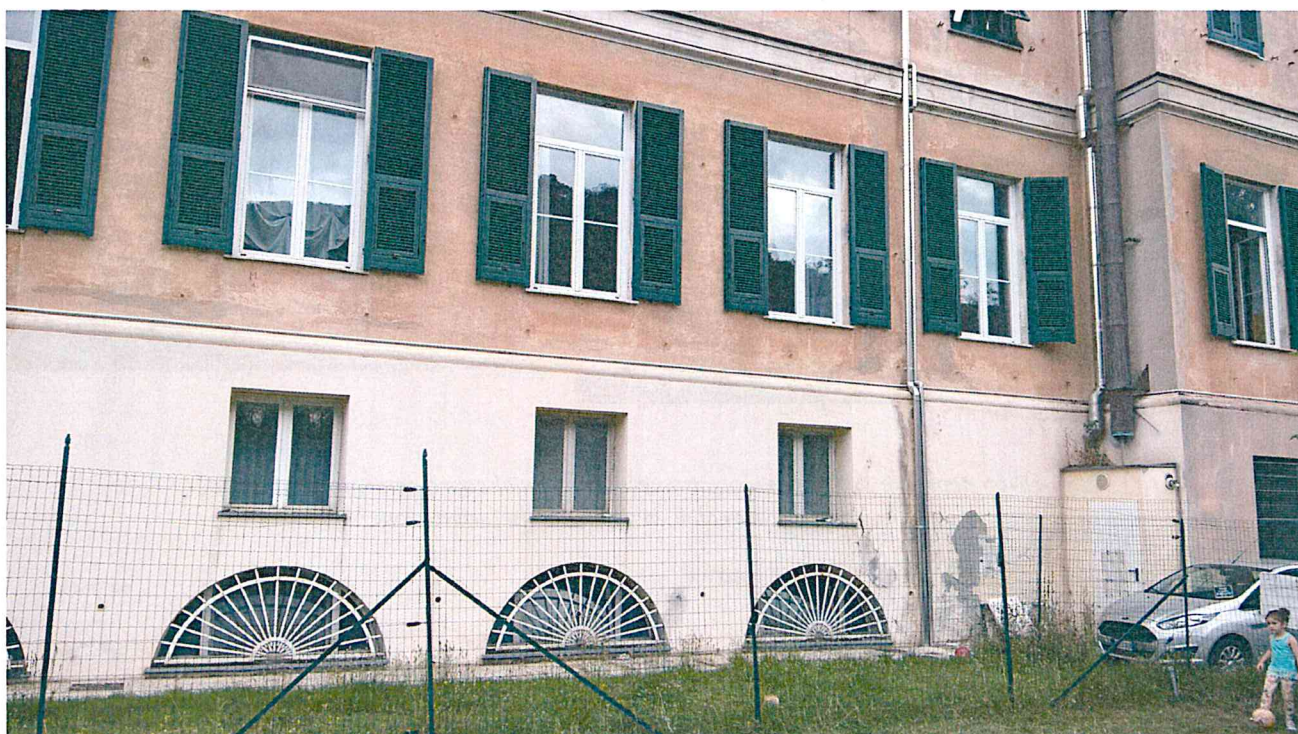
Img. 17-18 – Ala laterale verso ovest oggetto di precedente intervento al piano terra con rifacimento di intonaco su preesistente stollato e nuova pitturazione al quarzo. Nel dettaglio sottostante sono visibili esfoliazioni dello strato di coloritura
