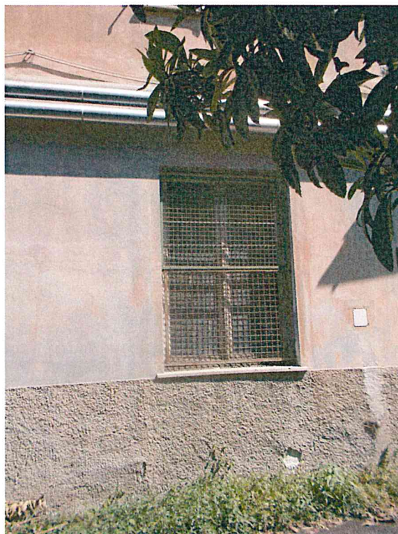
Img. 10 -11-12 – dettagli facciata principale, con depositi superficiali, lacune, distacchi di intonaco, fessurazione della sagoma decorativa del basamento tra piano terra e piano primo, in parte nascosto dalle tubazioni dell'impianto di riscaldamento, decoesione e rigonfiamenti della fascia a stollato
