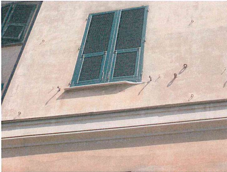
Img. 13-14-dettaglio prospetto centrale, con lacuna di un davanzale in marmo e della copertina in ardesia che riveste il cornicione tra piano primo e secondo
