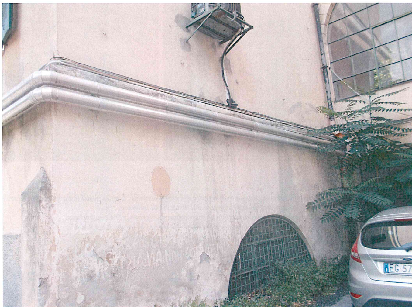
Img. 7 prospetto laterale est, dettaglio piano terra: esfoliazione strato di coloritura sovrapposto all'originale
