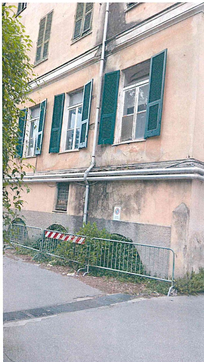
Img. 1-2- angolo tra ala est e prospetto laterale verso Asl: presenza di macchie, rottura dei pluviali, presenza di vegetazione infestante negli attacchi a terra e di patina biologica lungo le vie di percolazione dell'acqua. Sono inoltre visibili erosione, distacco e lacuna delle malte di rivestimento
