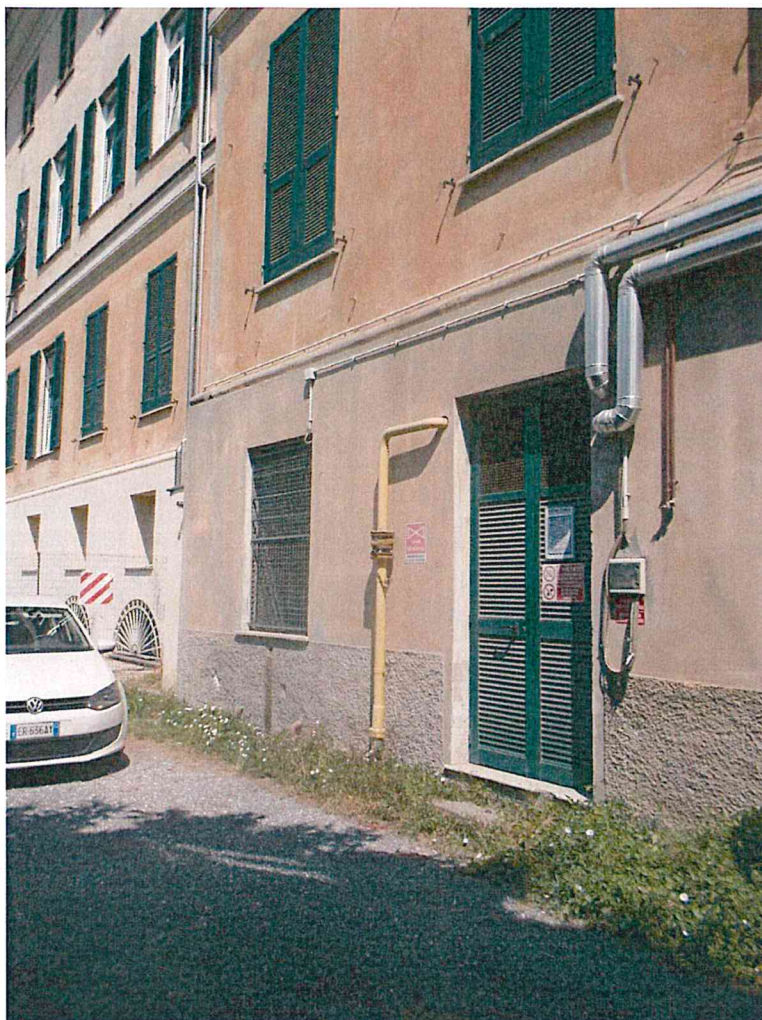
Img. 9 -10– corpo centrale in aggetto: a piano terra ingresso locale caldaia, vegetazione infestante all'attacco della muratura, sulla sinistra si intravede l'ala occidentale, il cui piano terra è stato oggetto di precedente intervento. Nella foto di dettaglio sottostante sono visibili fenomeni di erosione e l'alterazione cromatica della fascia a piano terra
