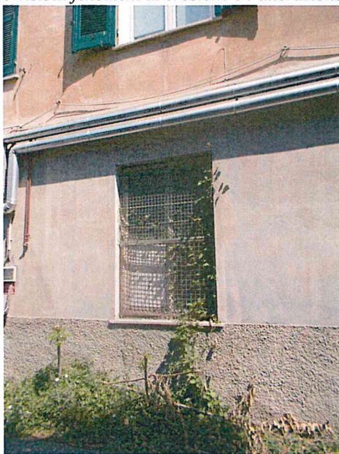
Img. 9 -10– corpo centrale in aggetto: a piano terra ingresso locale caldaia, vegetazione infestante all'attacco della muratura, sulla sinistra si intravede l'ala occidentale, il cui piano terra è stato oggetto di precedente intervento. Nella foto di dettaglio sottostante sono visibili fenomeni di erosione e l'alterazione cromatica della fascia a piano terra
