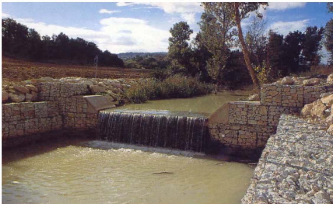
Figura 10 Tipologia di briglia in gabbioni.
