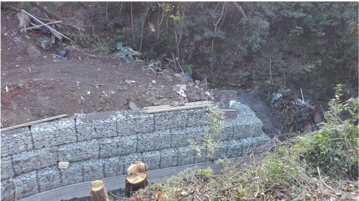
Figura 7 Sponda sinistra dopo la realizzazione dell'arginatura.
