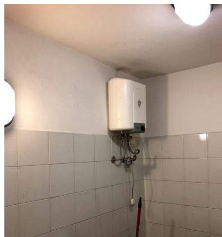
Figura 24: boiler elettrico ACS
