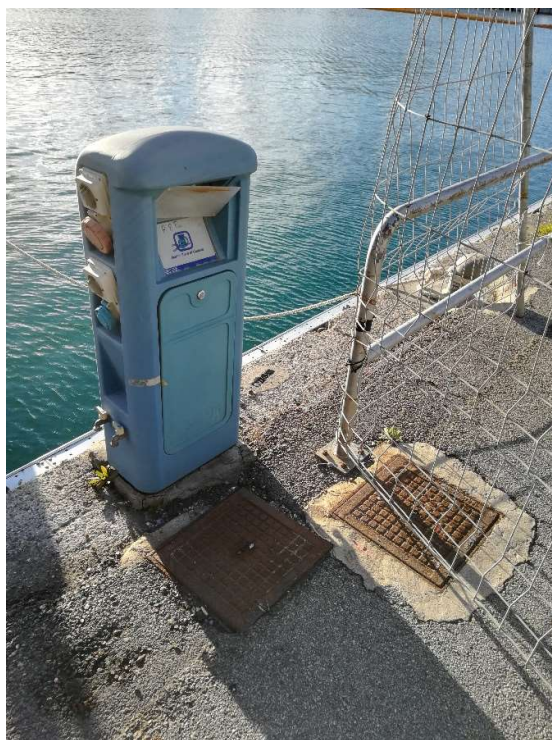
Figura 8. Banchina sud - Foto di una delle colonnine di distribuzione da sostituire
