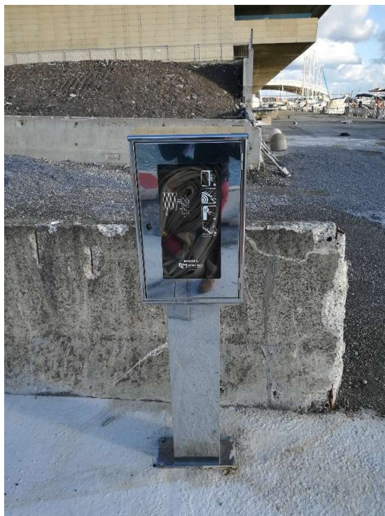
Figura 7. Foto della cassetta idrante UNI 45 in acciaio inox banchina est
