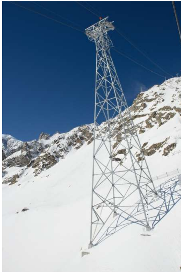
Fig. 8 – Uno dei sostegni in linea dell'impianto Skyway Monte Bianco, di altezza 100m.
