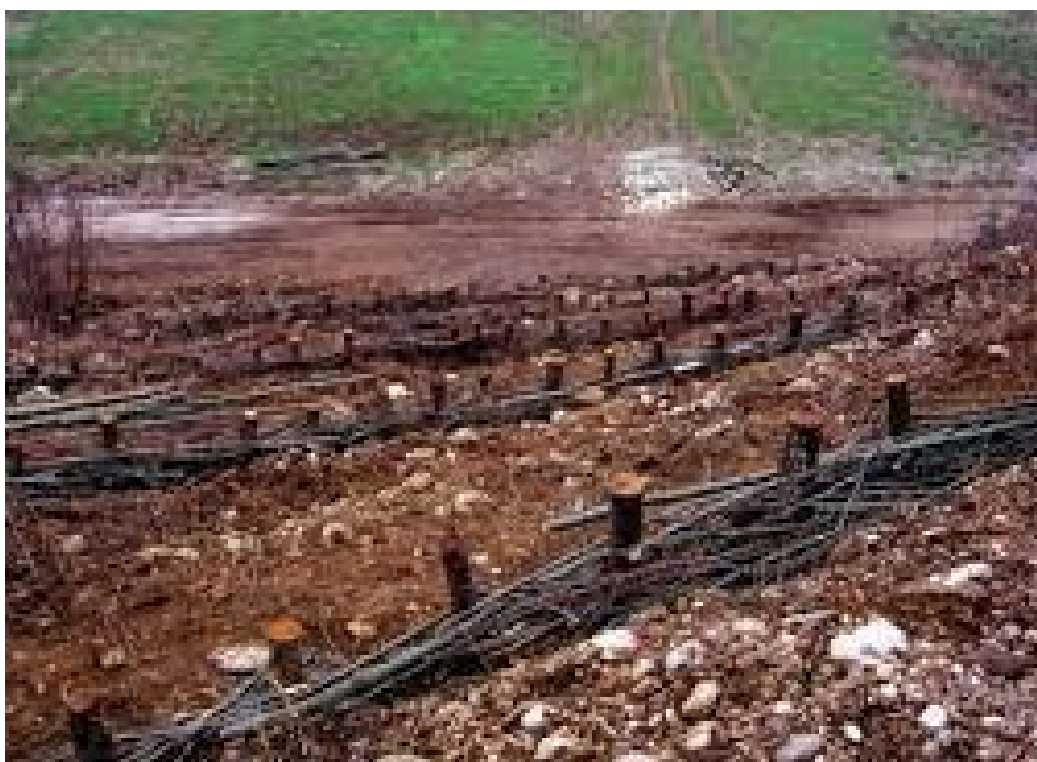
Foto 33 - Esempio di viminate.
