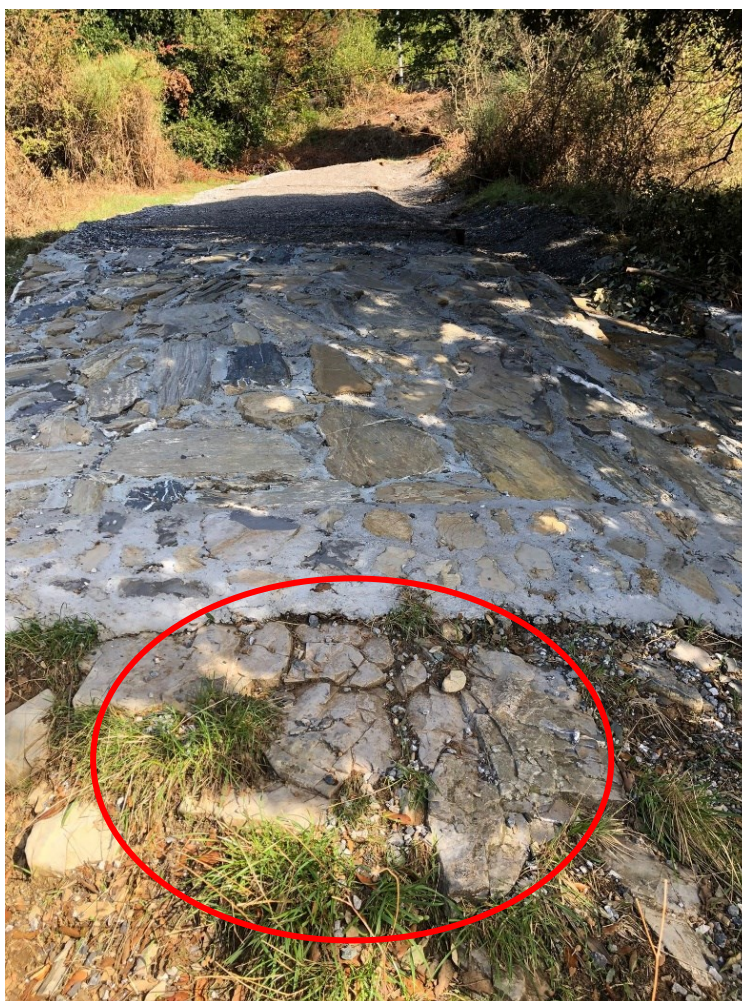
Foto 27 - Tratto di S1 realizzato in pietre cementate (campo prove Via Fea). L'effetto finale di questa tipologia di messa in opera sarà quello evidenziato nella parte bassa della foto.
