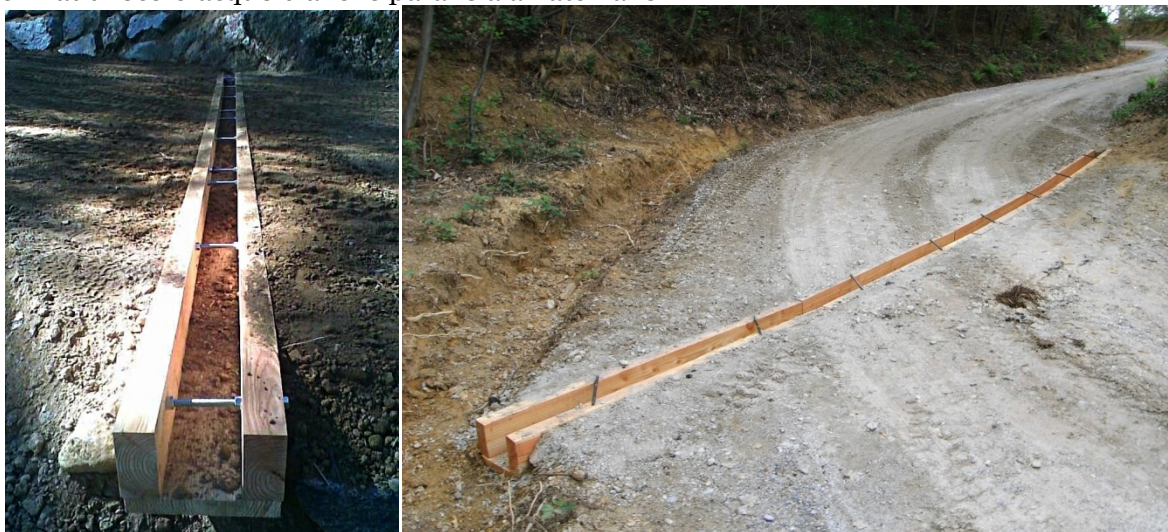
Foto 30 e 31 - Canalina trasversale al tracciato per lo scolo delle acque bianche.
