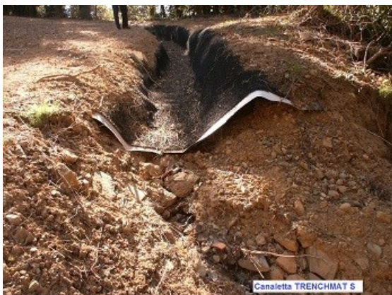
Foto 28 e 29 - Canaletta tipo Trenchmat per lo scolo delle acque bianche.
