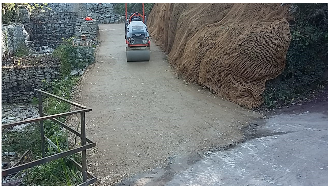
Foto 25 - Fasi di messa in opera del percorso S1 senza stabilizzanti.
