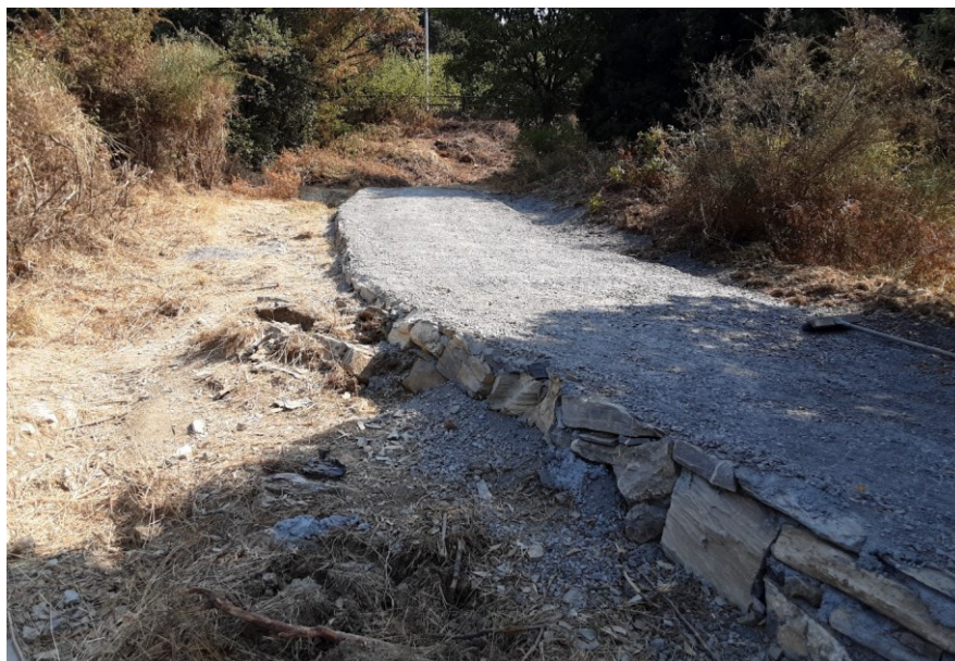
Foto 24 - L'aspetto finale di "S1" con aggiunta di leganti è quello di una normale strada bianca.
