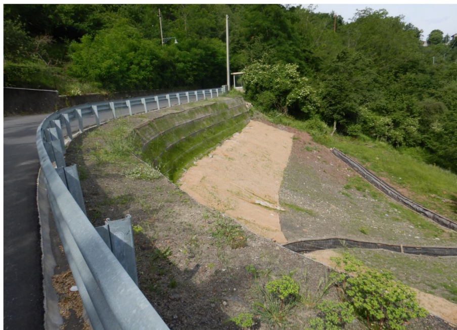
Foto 36 – Esempio di terre rinforzate a sostegno di carreggiata stradale.
