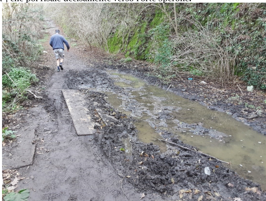
Foto 17 – Ristagno idrico pressoché permanente nel punto più basso del tratto a “corda molla”.
