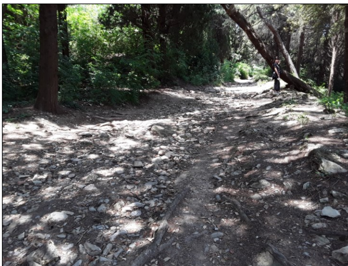
Foto 10 - La sede della strada bianca dissestata che necessita di rifacimento della massicciata, regimazione delle acque e potatura alberi.
