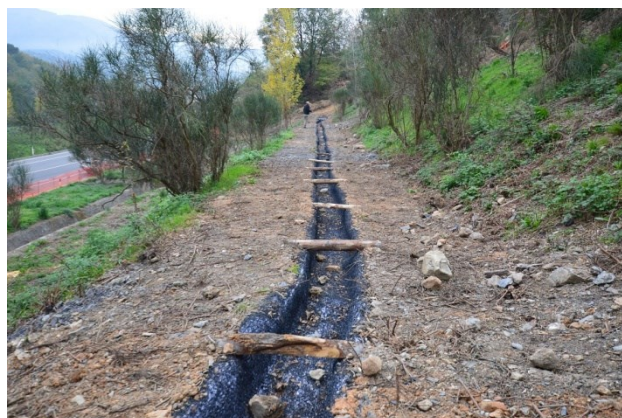
Foto 28 e 29 - Canaletta tipo Trenchmat per lo scolo delle acque bianche.
