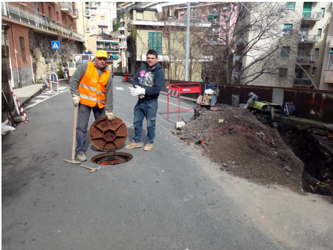
Foto 6: Pozzetto su attuale rete mista nel tratto mediano di Via Robino con scavo ispettivo
