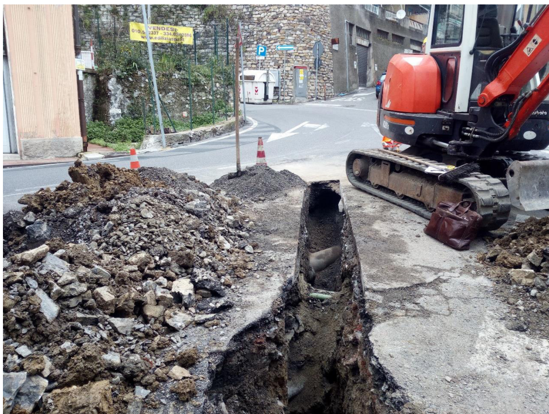
Foto 8: Scavo ispettivo nel tratto alto di Via Robino
