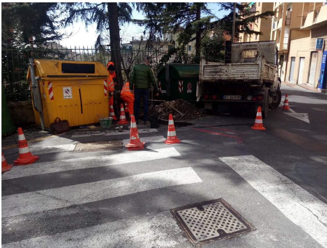
Foto 7: Scavo ispettivo nel tratto alto di Via Robino
