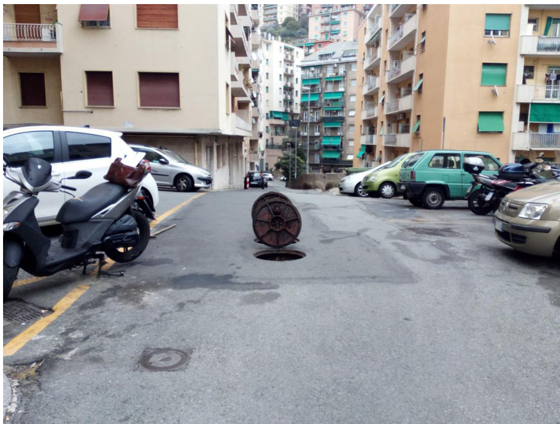
Foto 10: Pozzetti di recapito finale reti bianca e nera Via Ameglio
