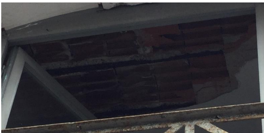
Foto 7: Solaio sfondellato
