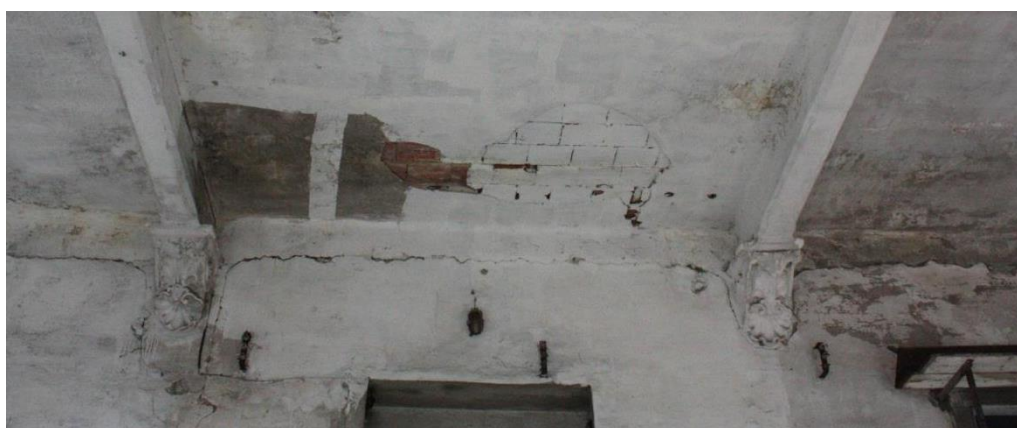
Foto 19: Mancanza di ammorsamento trave-pilastro e tamponamento
