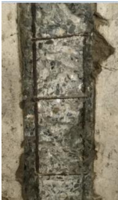
Foto 14: Pilastro c.a. e armature
