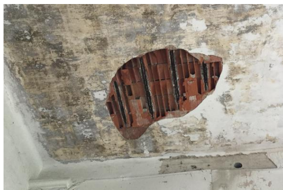
Foto 21: Solaio sfondellato
