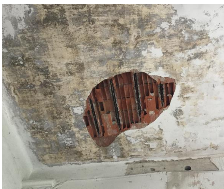
Foto 8: Solaio sfondellato
