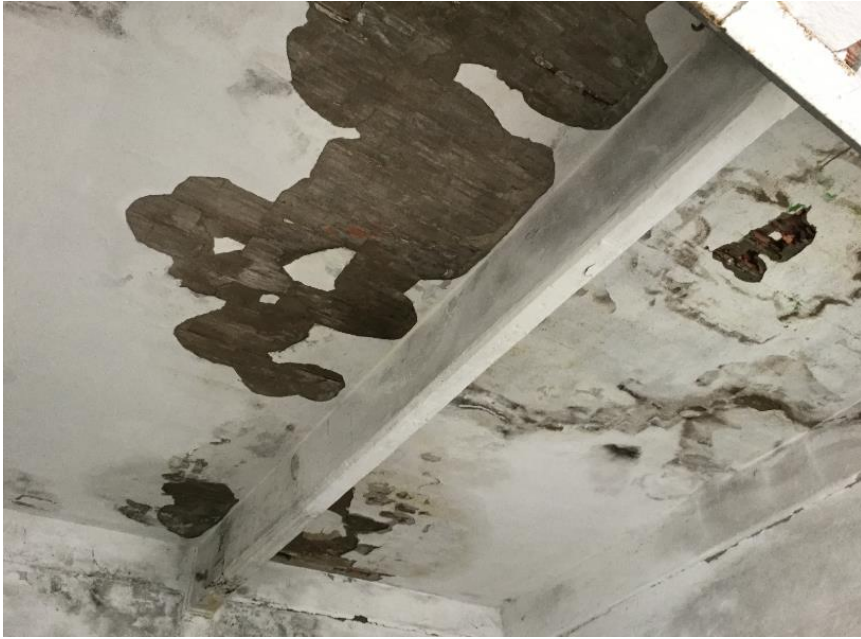
Foto 2: Trave c.a. e solai latero cementizi
