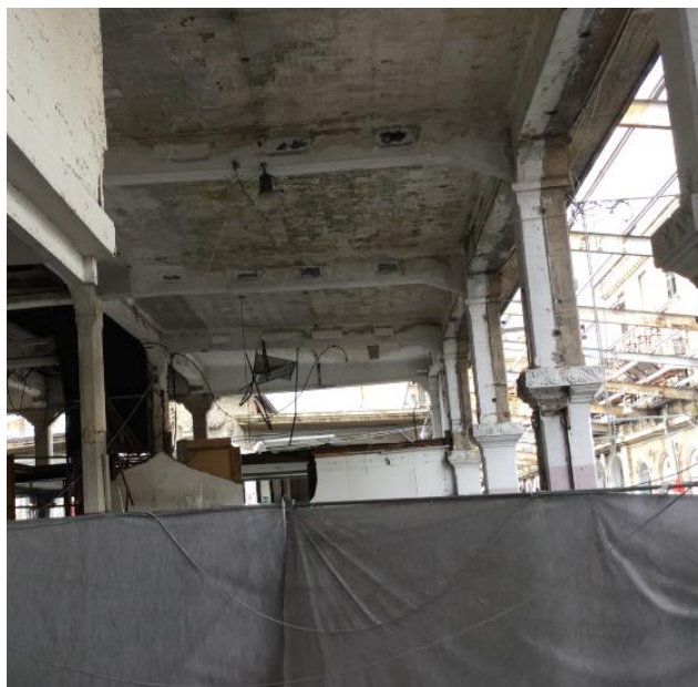
Foto 12: Vista edificio centrale con travi forate
