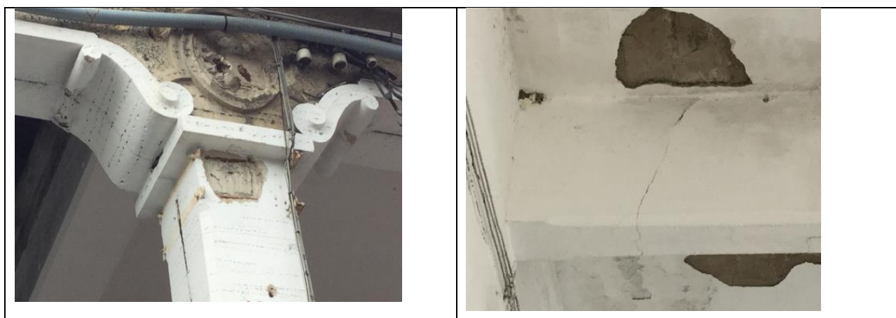
Foto 20: Espulsione del copriferro e lesione su trave
