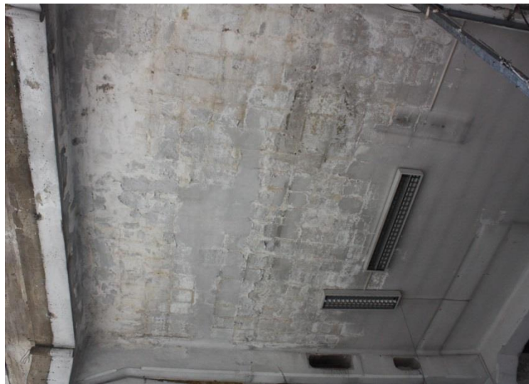
Foto 16: Efflorescenze saline
