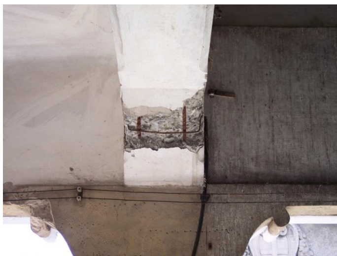
Foto 17: Espulsione del copriferro e corrosione armatura
