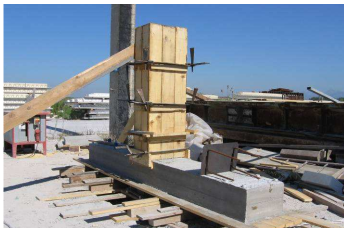
Figura 8 - Fasi di realizzazione di un campione gettato in opera (serie OP)
