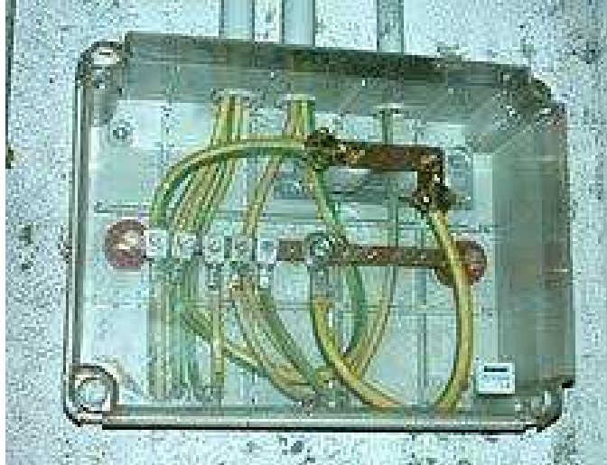
Figura 8: Esempio di installazione di barra equipotenziale all'interno di cassetta autoestinguente
