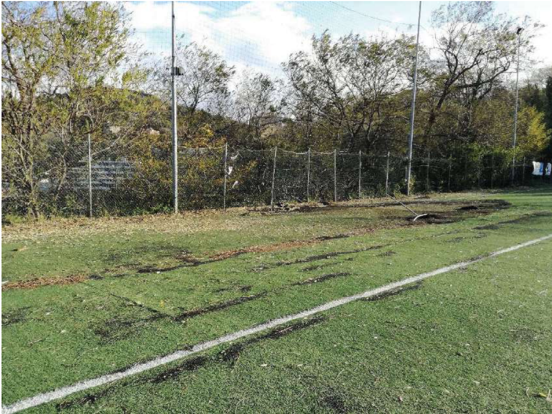
Foto 1 – Evidenze del cedimento che interessa l'angolo NW del campo.
