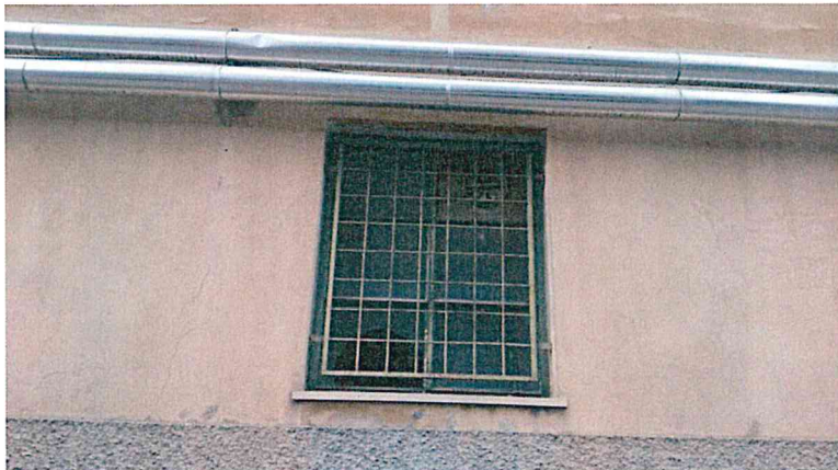
Foto 34 35—dettaglio serramenti esistenti del piano terra da sostituire o manutenzione (corpo centrale, locale caldaia)
