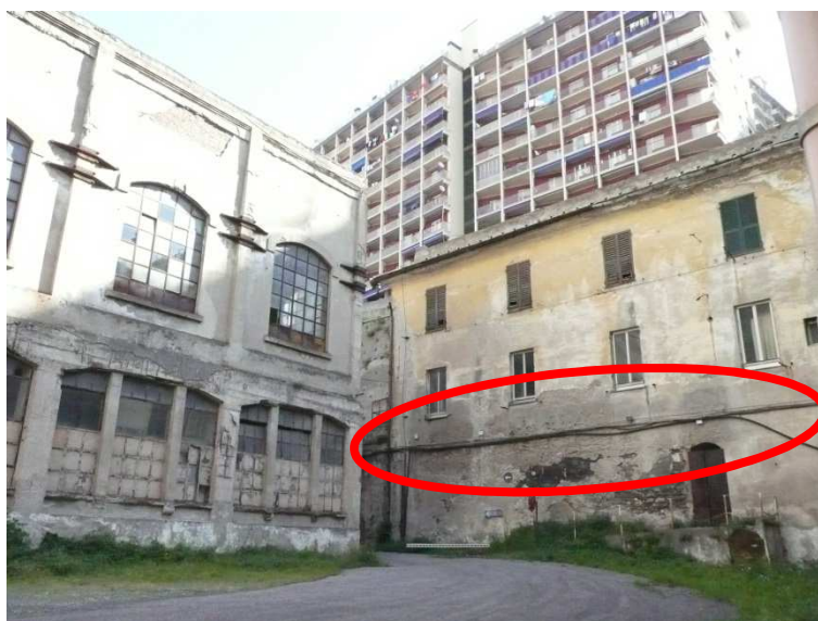
Figura 3.5: Rete idrica staffata all'edificio A
