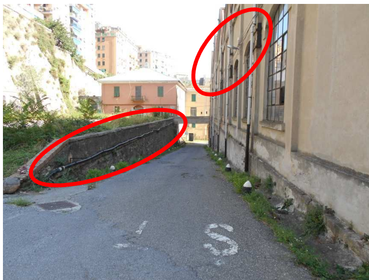
Figura 3.4: Rete dati staffata all'edificio B e rete idrica staffata al muro di sostegno
