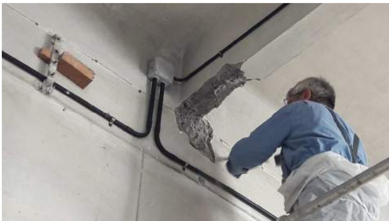
Figura 7. Saggio sulla trave ricalata del solaio di copertura dei laboratori – estremità (dettaglio 4)
