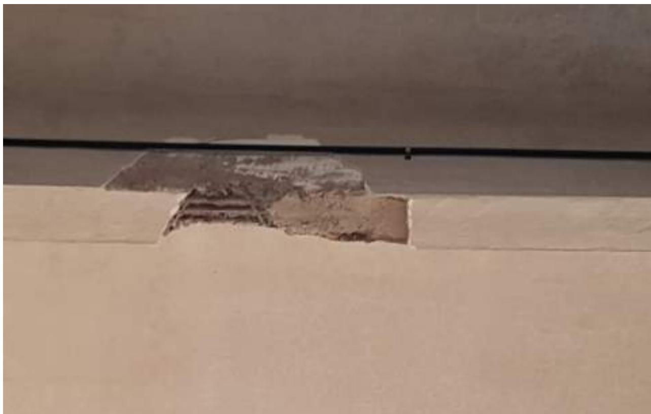
Figura 6. Saggio sulla trave ricalata del solaio di copertura dei laboratori – mezzeria (dettaglio 3)
