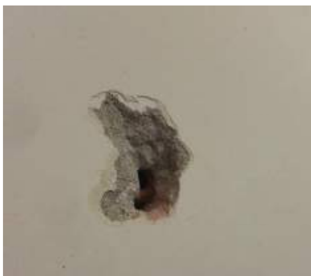
Figura 3. Particolare del saggio sulla muratura tra palestra e corridoio
