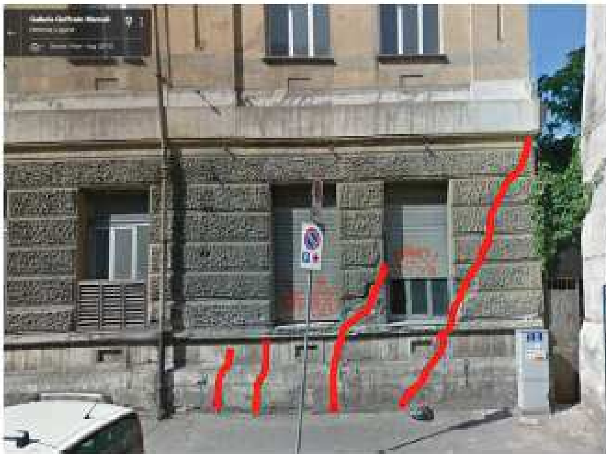
Figura 3. Prospetto della parete lesionata con indicazione delle lesioni
