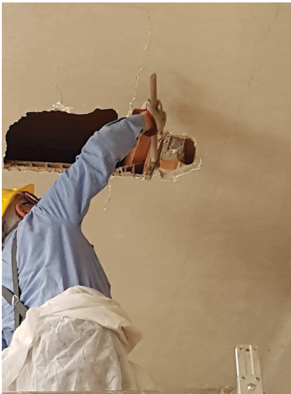
Figura 5. Saggio sul solaio di copertura dei laboratori – porzione centrale (dettaglio 2)
