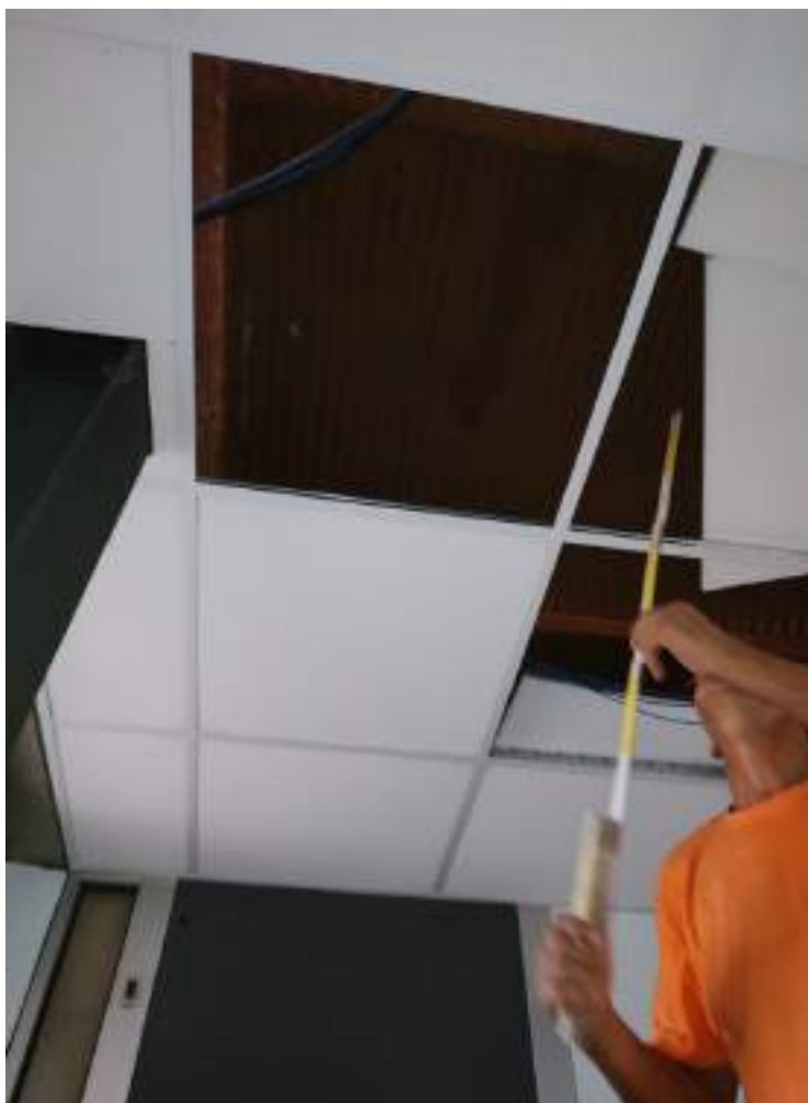
Figura 4. Ulteriore saggio interno a soffitto piano primo nella zona dove sarà inserita nuova piattaforma elevatrice per verifica orientamento travetti solaio
