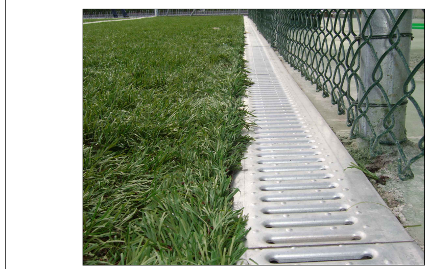
Dettaglio canaletta perimetrale: dim.200x150 mm - pendenza 0,5% (di cui all'elaborato grafico EG.16)
