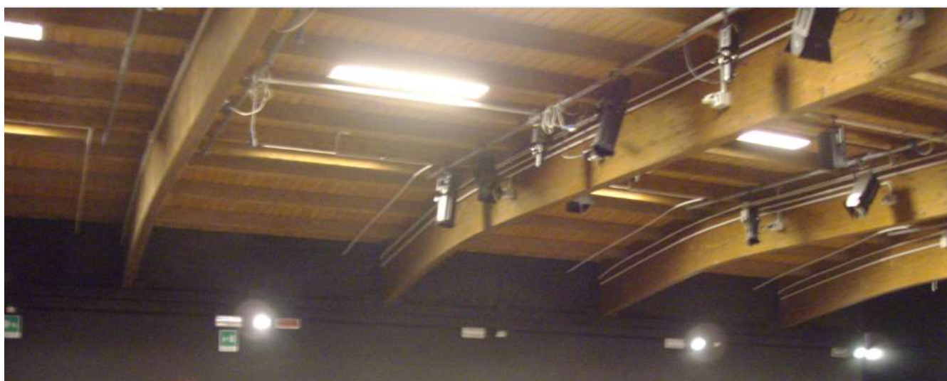
Foto 4 –Foto 5 Dettaglio interno copertura teatro impiantistica da smontare/rimontare dopo trattamento ignifugo degli elementi lignei – esterno copertura piana
