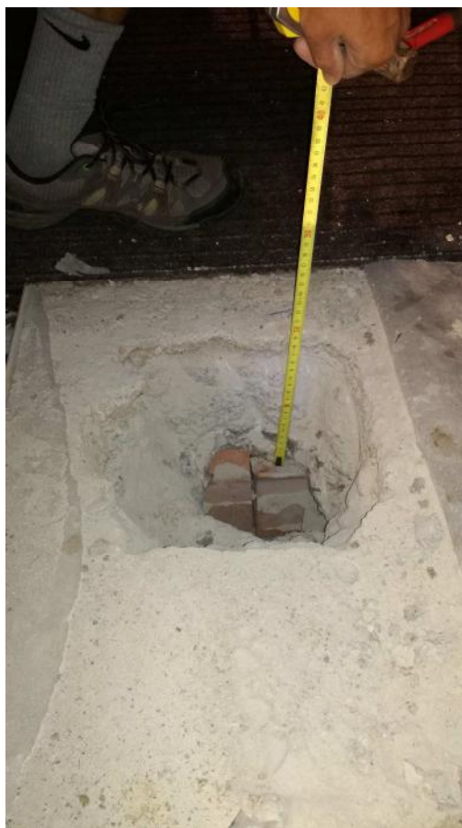
Figura 28 Spessore porzione cls del solaio
