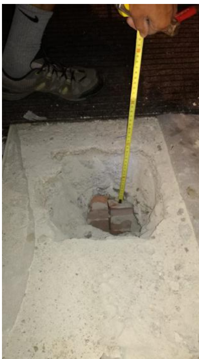
Foto 4-6. Struttura del solaio e panoramica del vano esistente sotto il solaio.
