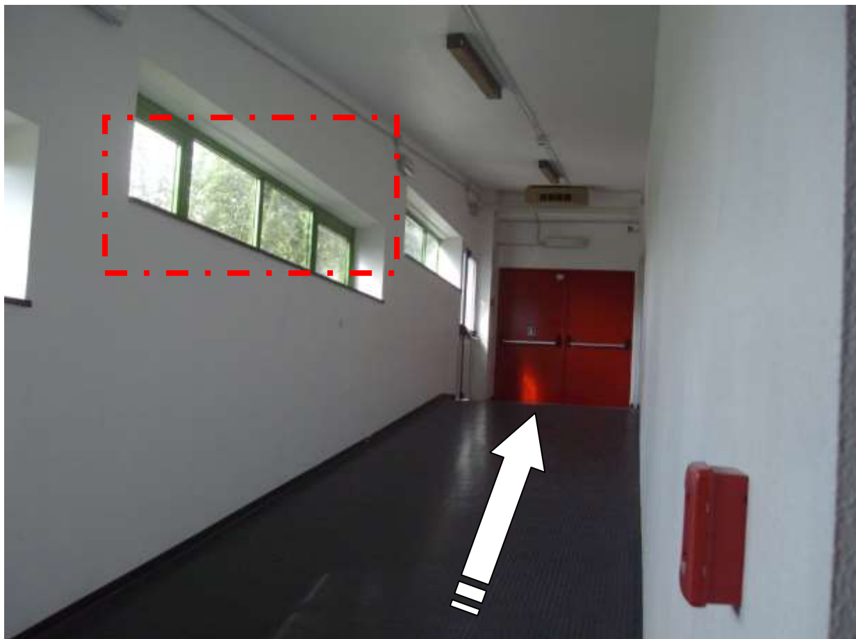
Foto 9 Zona Filtro – Adeguamento pendenza rampa – sostituzione infisso con persiane aerazione
