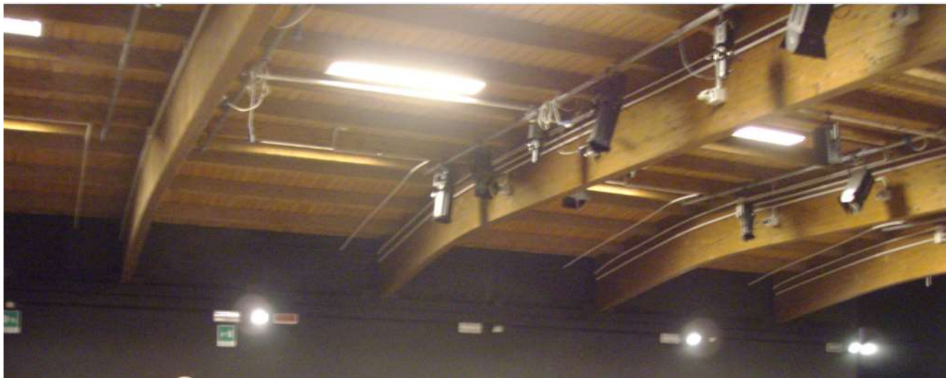
Figura 3 –Dettaglio interno copertura teatro impiantistica da smontare/rimontare dopo trattamento ignifugo degli elementi lignei – esterno copertura piana
