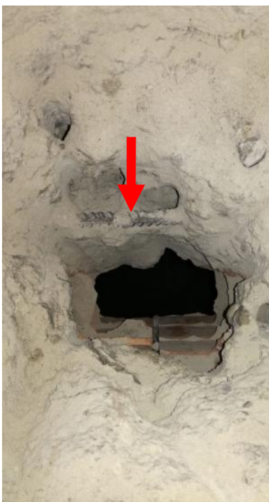
Foto 4-6. Struttura del solaio e panoramica del vano esistente sotto il solaio.
