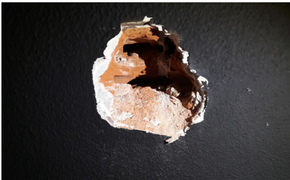
Figura 1. Particolare del saggio interno sulla muratura perimetrale sala dove sarà realizzato il varco di collegamento ai nuovi locali camerini
