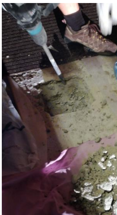
Foto 1-3. Fasi di realizzazione della foratura del solaio.
