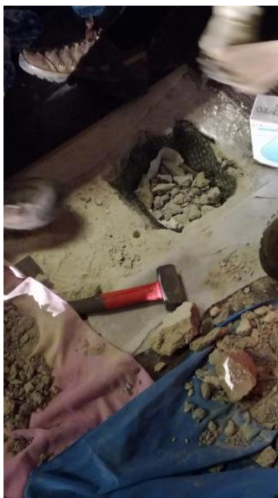
Foto 7-9. Fasi di ripristino della foratura.
