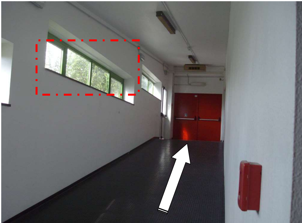
Figura 12 –Zona Filtro – Adeguamento pendenza rampa – sostituzione infisso con persiane aerazione
