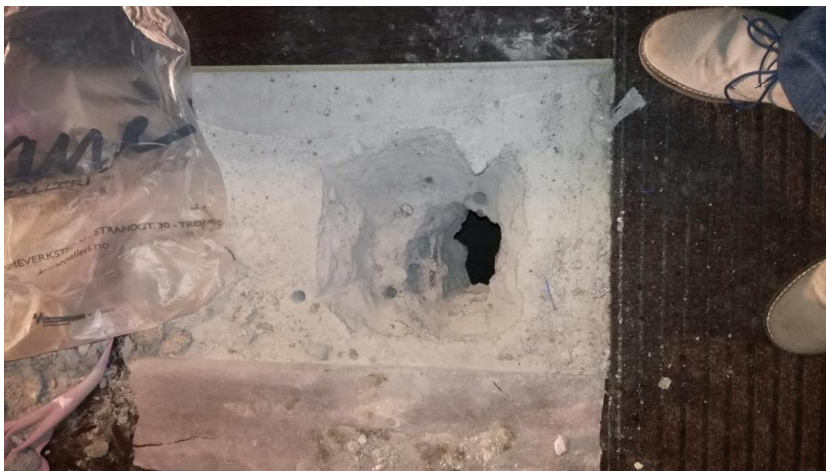
Figura 27 Solaio Sfondato (l'ingresso del teatro è a sinistra della foto – le scale e la porta di emergenza sono a destra)
