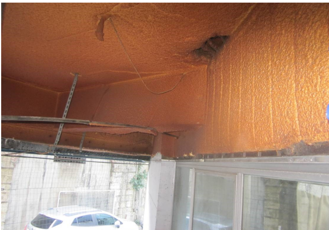
Note: Presenza di pannelli di lamiera gregata di tamponamento con protezione antincendio Foto 4BS
