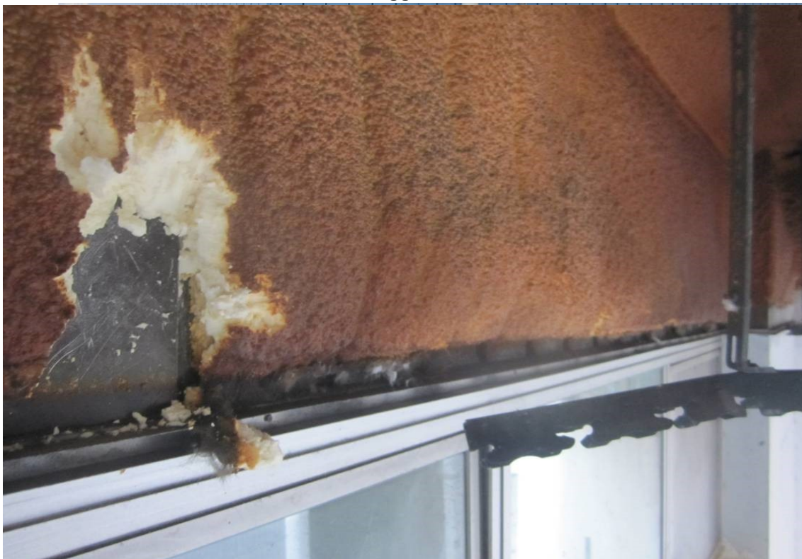
Note: Presenza di pannelli di lamiera gregata di tamponamento con protezione antincendio Foto 3BS
